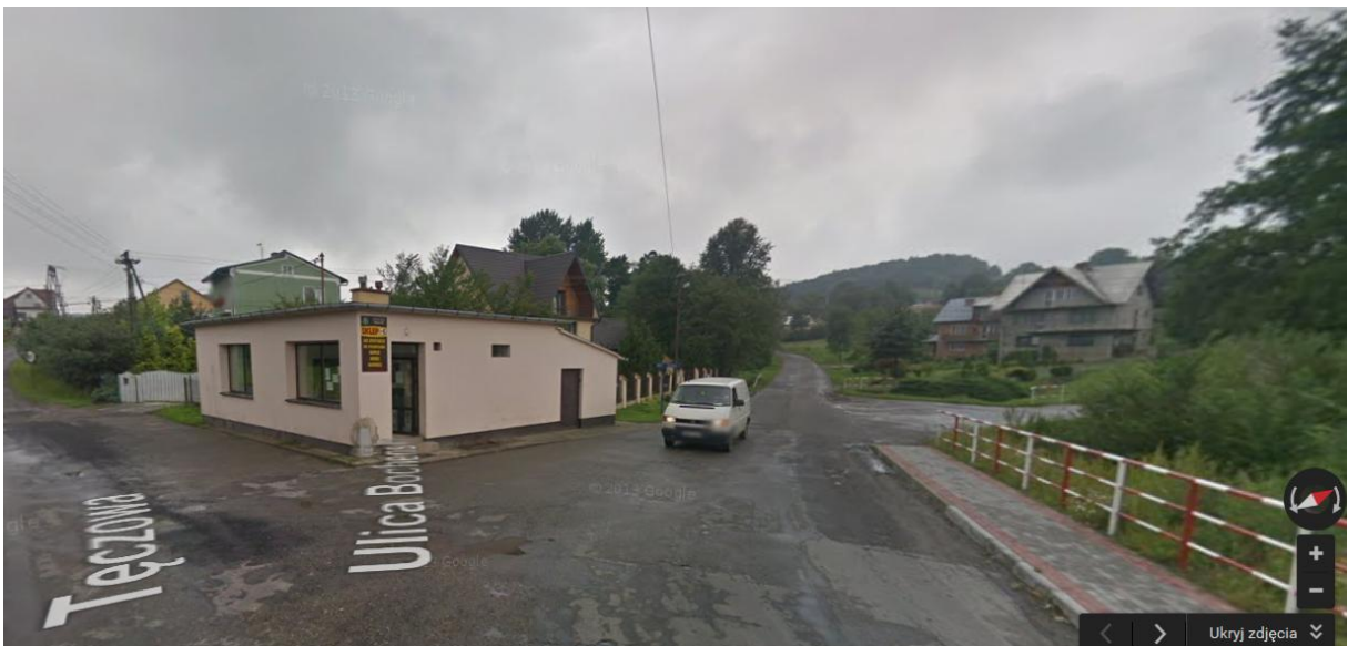
Zdjęcie 1 – Brzeg prawy, km 3,100. Poręba Spytkowska, ul. Bocheńska, widok na sklep GS i 2 mostki.
